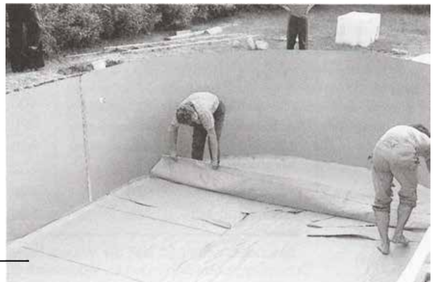
Raum für Magerbeton- Hinterfüllung
